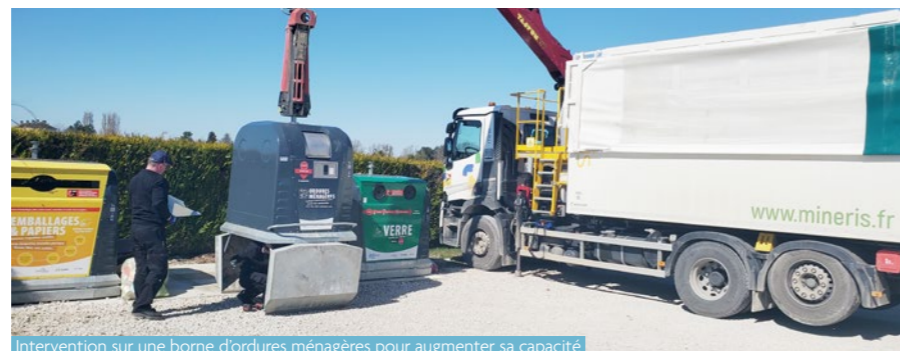
Intervention sur une borne d'ordures ménagères pour augmenter sa capacité
